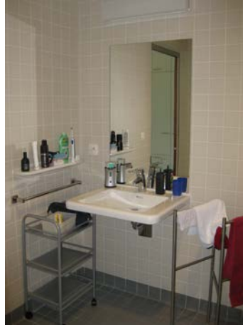
Onderrijdbare wastafel met tablet aan linkerkzijde waardoor benodigdheden binnen handbereik staan
