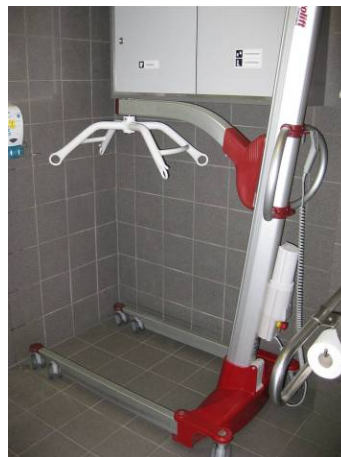
Nis voor het stallen van tilliften. Combinatie met opbergruimte. Mané vzw, © Enter vzw
