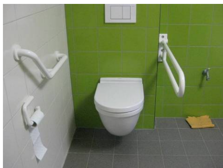
Aangepast toilet met 1 transferzijde.
