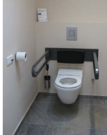
Verlengd toilet met rugsteun en opklapbare beugels UD Woonlabo, © Toegankelijkheidsbureau vzw
