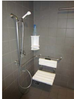
Wegneembare douchezit en hoekwandbeugel die ook als gleistang gebruikt wordt. Mané vzw, © Enter vzw
