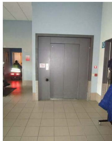
Voor de lift er is er voldoende manoeuvreerruimte aanwezig. Deze is ook volledig buiten de andere circulatiezones gelegen.
