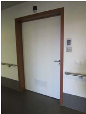
Afgebogen leuning bij de onderbreking aan een deur. Revalidatiecentrum UZ Gent, © Enter vzw
