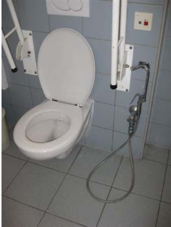
Extra kraantje met sproeier o.a. voor het uitspoelen van een urinaal St. Lodewijk vzw, © Enter vzw
