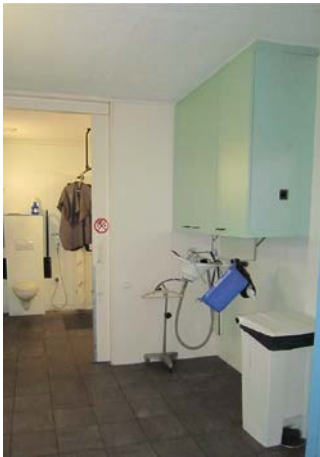
Bergruimte op hoogte aan een badkamer, zo blijft de nodige manoeuvreerruimte vrij op vloerniveau voor het draaien met rolstoelen of het gebruik van tilhulpmiddelen.
