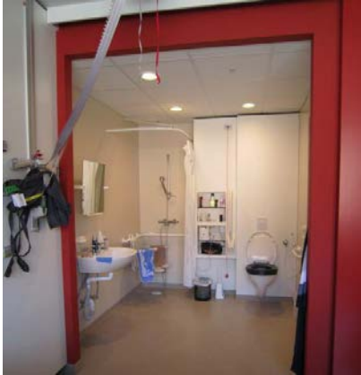
Sanitaire cel aan een kamer met zorgwand. Revalidatiecentrum UZ Gent, © Enter vzw
