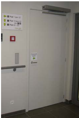
Automatische draaideur met drukknop. Woonvorm Koersel, © Toegankelijkheidsbureau vzw
