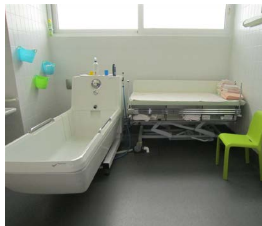
Hoog-laag bad met aangrenzend een in hoogte verstelbare verzorgingstafel. Zorgcentrum Maria - Ter - Engelen vzw, © Enter vzw
