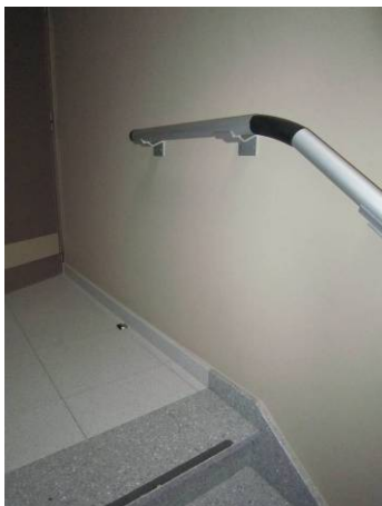
Doorlopende leuning na het einde van de trap. Zorgcentrum Maria - Ter - Engelen vzw, © Enter vzw
