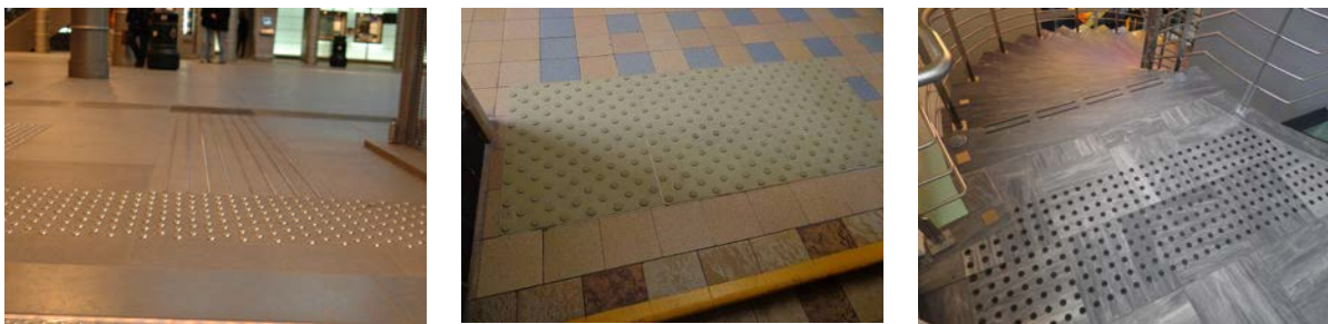
Verskillende toepassingen van hetzelfde principes kan. Bijvoorbeeld het aanbrengen van noppen in verschillende materialen: noppen in roestvast staal, verlijmd kunststof stroken en antislip noppen. Antwerpen centraal, Koninklijk Instituut Woluwe, Enter vzw, ©Enter vzw
