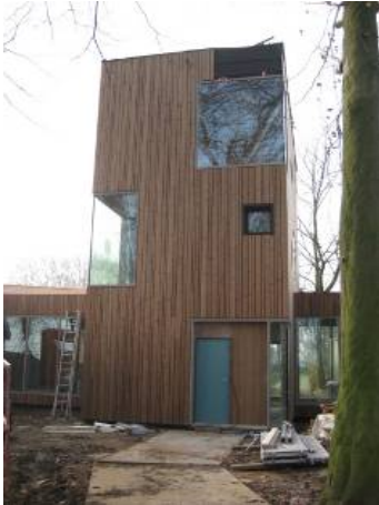
Bij de nieuwbouw wordt een sas gebruikt met een geschrante opstelling van de deuren. Dominiek Savio Instituut, © Enter vzw
