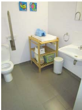
Aangepast toilet met een verzorgingstafel. Let wel, de verzorgingstafel verspert de transferruimte. KiDs vzw vzw, © Enter vzw
