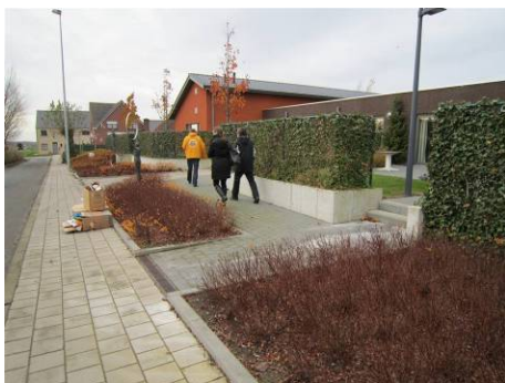
Een combinatie helling en trap geïntegreerd in de omgevingsaanleg: kleine helling naar de trap, het pad loopt in helling verder rond de haag naar de toegangsdeur.
