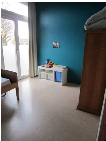
Kamerhoog raam met visuele afscherming aan de onderzijde. Zorgcentrum Maria - Ter - Engelen vzw, © Enter vzw
