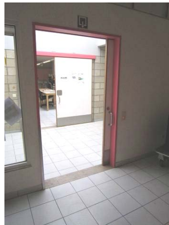
Schuifdeur met brede dagmaat voor dagelijkse passage met elektrische rolstoelen.
