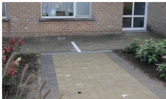
Rooster dwars op de circulatierichting. Groenaanplanting vormt een natuurlijke vorm van geleiding. St. Lodewijk vzw, ©Enter vzw
