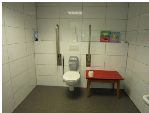
Aangepast toilet met 2 transferzijden en 2 opklapbare beugels, voorzetwand over de volledige breedte van de ruimte waardoor een beperkte zitdiepte.
