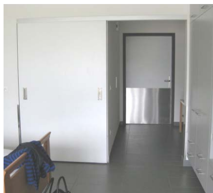
In open stand is de badkamer vlot toegankelijk en wordt de inkomhal afgesloten om de privacy te verzekeren. De schuifdeur heeft aan twee zijden een ingebouwde greep. Er kan een opbouwgreep worden geplaatst als de bewoner dat wenst.
