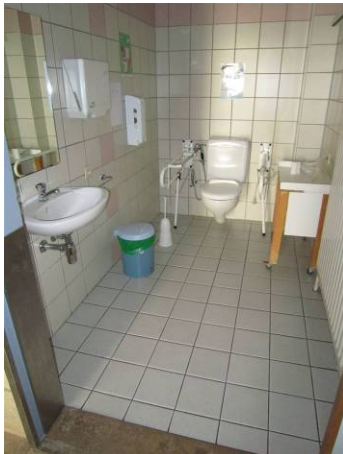
Semi-ambulant toilet. St. Lodewijk vzw, © Enter vzw
