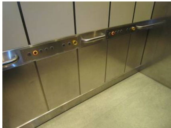
Horizontaal bedieningspaneel en handgrepen in de lift.
