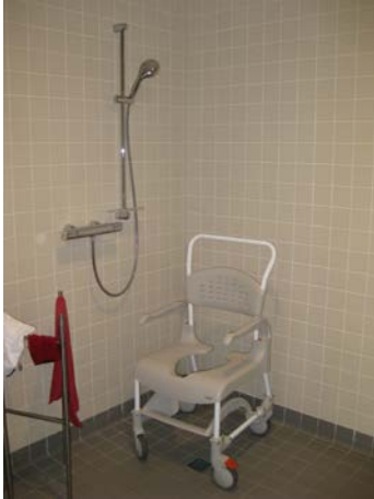
Verrijdbare douche-toiletstoel op een drempelloos doucheoppervlak Sint - Gerardus Diepenbeek, © Toegankelijkheidsbureau vzw
