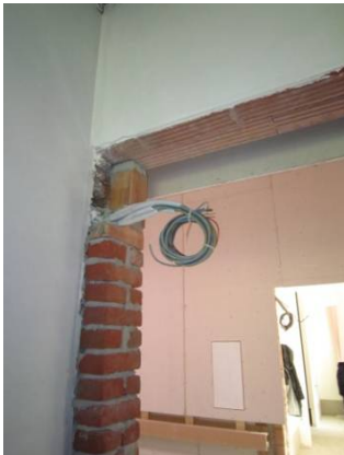
Aansluiting voor deurautomatisatie in ruwbouwfase. Dominiek Savio Instituut, © Enter vzw
