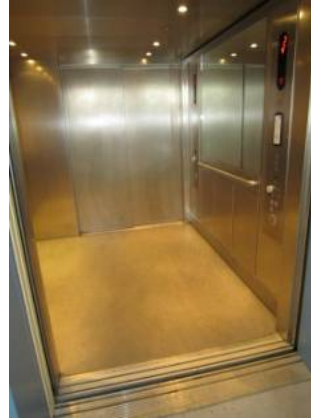
Grote liftkooi, bruikbaar met meerdere rolstoelgebruikers tegelijk. St. Lodewijk vzw, © Enter vzw
