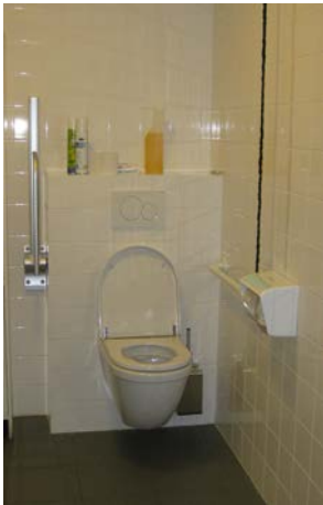
Alarmkoord in aangepast toilet. DVC De brug – Heusden-Zolder ©Toegankelijkheidsbureau vzw
