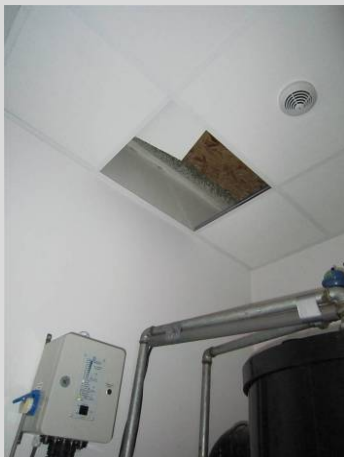
Berging die later liftschacht kan worden. KiD vzw, ©Enter vzw
