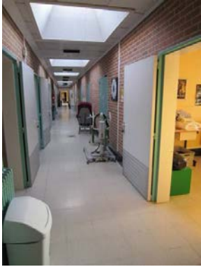
Deuren met stootboorden in staalplaat. Dominiek Savio Instituut, © Enter vzw
