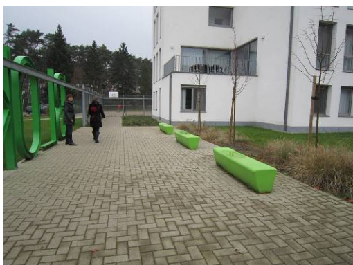
Rustpunten op een route, buiten de circulatiezone gelegen.
