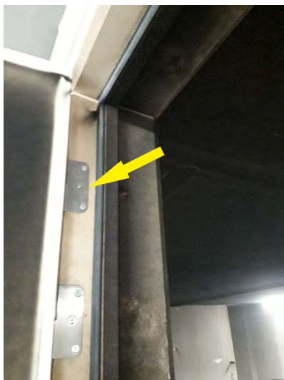
Rookwerende deur ("propere" omlijsting links naast aanslag)
