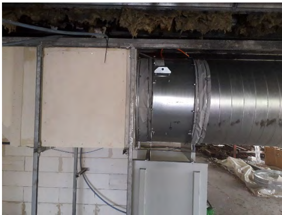
Detail rechthoekig kanaal – ventilator – cirkelvormig kanaal
