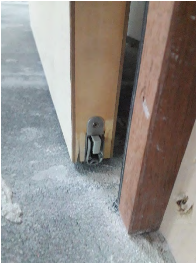
Figuur 7: Rookwerende deur (valdorpel – links; rubberen afdichting – rechts)
