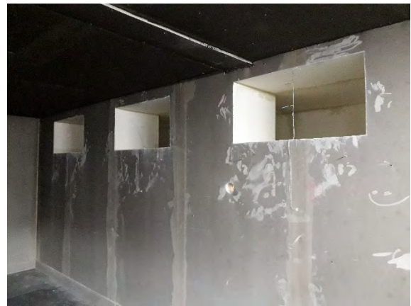
Afvoeropeningen in de gemeenschappelijke ruimte
