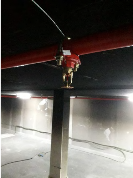
Detail residentiële sprinklerkop
