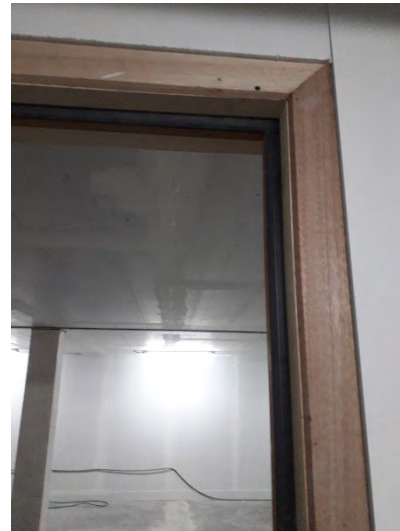
Figuur 7: Rookwerende deur (valdorpel – links; rubberen afdichting – rechts)
