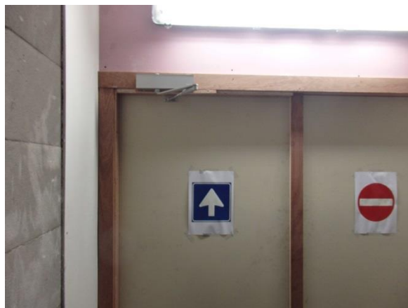
S-deur (zicht Gang 2)
