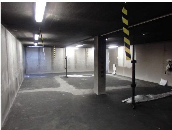
Afvoerventilator in gemeenschappelijke ruimte
